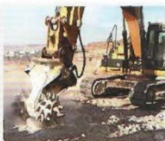
基础施工 Foundation construction
