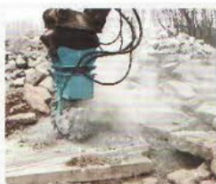
岩石铣挖 rock milling
